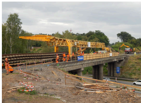
Posledním drážním vozidlem na mostě byl 2. srpna stroj PKP 25/20.1i snářející kolejová pole.
