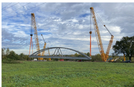
Mostní konstrukci z montážní polohy blíž k dálnici přiblížila 10. října dvojice jeřábů Liebherr LR 1750 o nosnosti 750 tun
