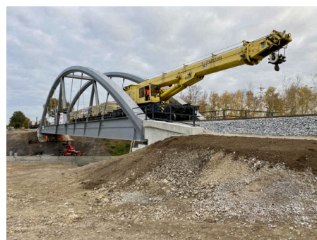
Statická zatěžovací zkouška se s využitím jeřábu KRC 800T a soupravy vozíků se silničními panely konala 31. října, v prvních dvou listopadových dnech proběhla ještě dynamická zatěžovací zkouška
