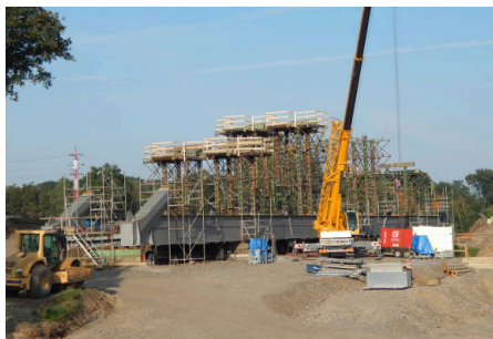
Nová konstrukce mostu byla montována na toušeňském předpolí, 1. září již bylo možno tušit její podobu
