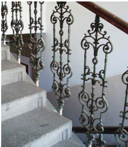
Ozdobné zábradlí u vnitřního schodiště
